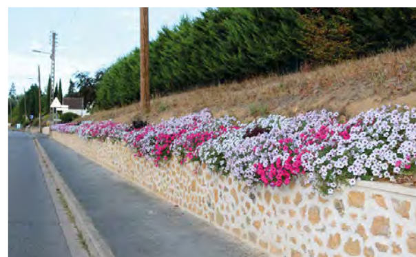
Rénovation et fleurissement du mur rue de Dampierre réalisés cet été.
