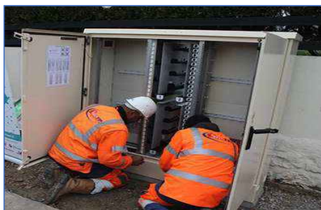
Point Mutualisation (Armoire de rue)
