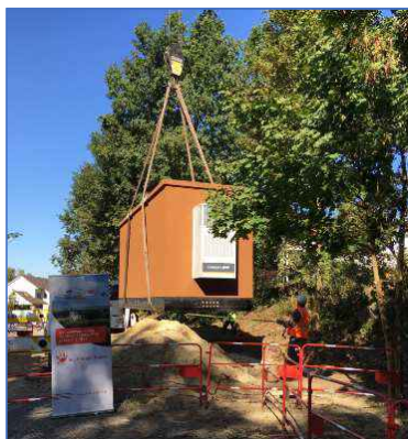
NRO : Nœud de raccordement Optique de Chevreuse
