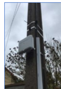
Point Branchement aérien
