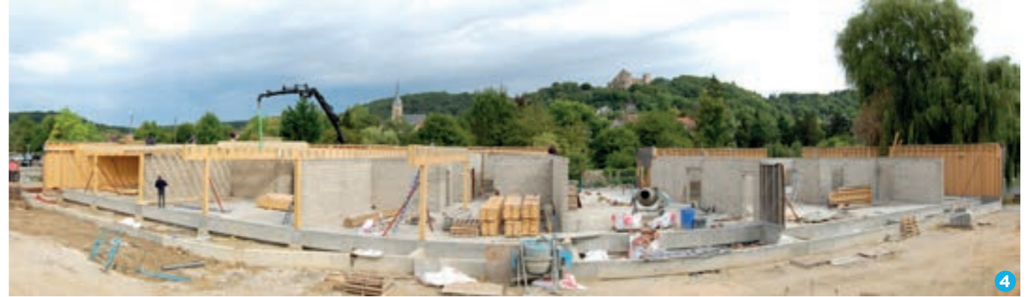
1. Coulage de la dalle de béton (en juin). 2. Montage des murs du bâtiments (en juillet). 3 et 4. Installation des structures de façade et de la charpente en bois (en août).
