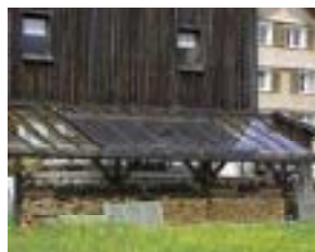
Les capteurs sont intégrés à la couverture d'une remise à bois. Maison individuelle (Vorarlberg, Autriche) © PNR du Vexin français
