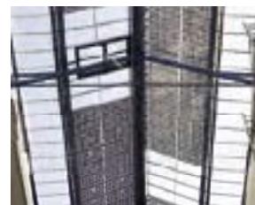
Les capteurs photovoltaïques sont intégrés à la verrière de la galerie de distribution d'une résidence HLM. L'Isle d'Abeau (Isère) © Photowatt
