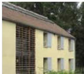
Un ensemble de capteurs thermiques souligne le faîtiage de la toiture. Centre médicalisé à Bullion (Yvelines), Cabinet Méandre, architectes © PNR Haute Vallée de Chevreuse
