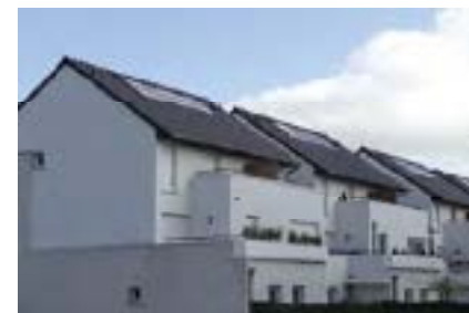
Les capteurs thermiques suivent la logique de composition des volumes de cet ensemble d'habitat collectif. Montigny-le-Bretonneux (Yvelines). © CAUE 78
