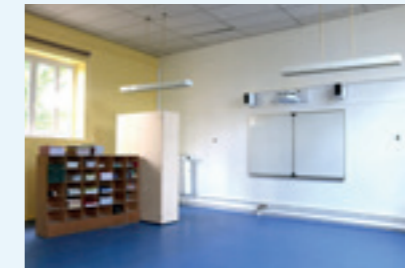
Remise en peinture d'une classe à l'école élémentaire Jean Moulin
