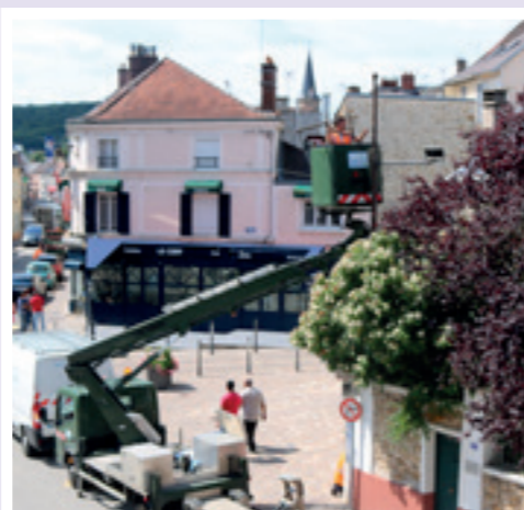
Durant tout l'été : Rénovation de l'éclairage public
