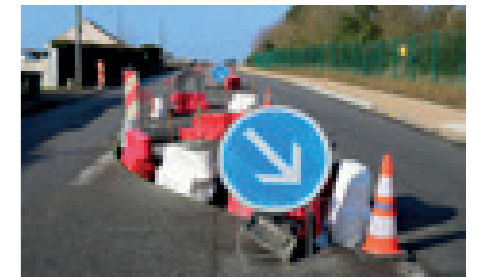
Photos du chantier le 13 février.
